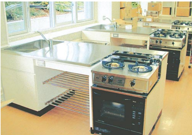
施工例(調理台)
